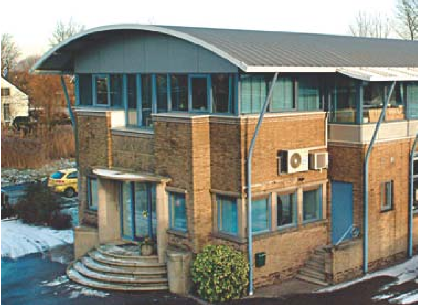
Restyling betonwarenfabriek De Ringvaart Hillegom (NL), 1995. Architect: Max van de Pol, Heemstede
