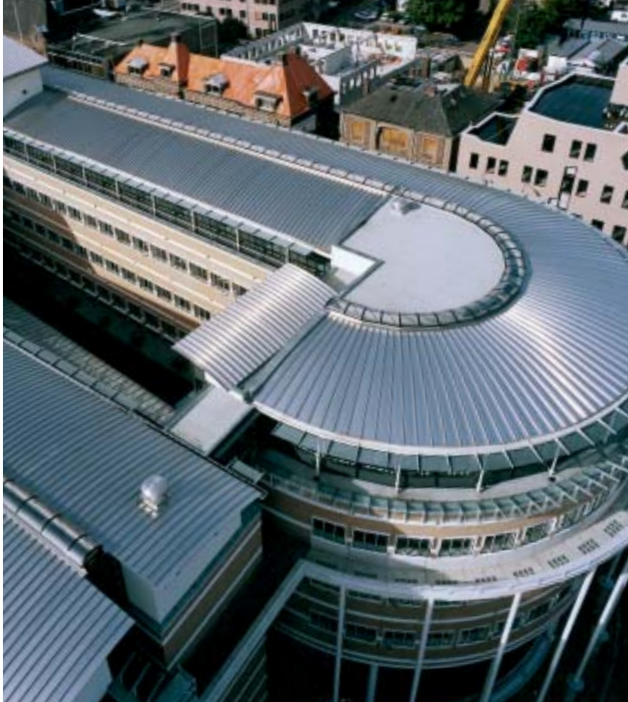
Stadhis Apeldoorn (NL), 1995. Kalzip® stucco naturel, rond gewalst, gedeeltelijk conisch. Architectengroep Amsterdam
