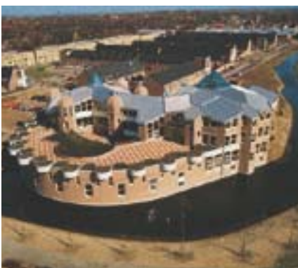
Gasbedrijf Heemskerk (NL) Architecten: P. Blom, H. van Eijk, Monnickendam
