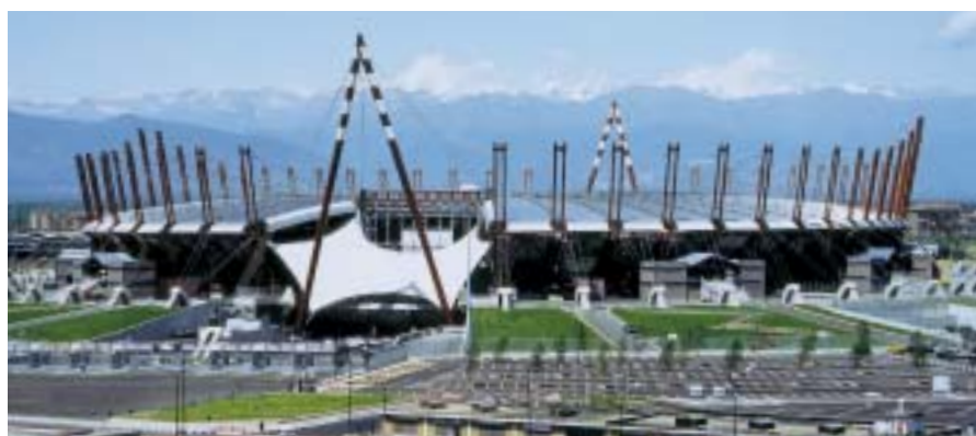
Stadion Turijn (I). 25.000 m 2 Kalzip® is hier op de bouwplaats geproduceerd. Daarvoor werd niet de fabriek naar Turijn verplaatst maar een kleine mobiele productie unit zorgde ervoor dat alles wat nodig was op tijd en op maat aanwezig was, tot verbazing van de bouwers.
