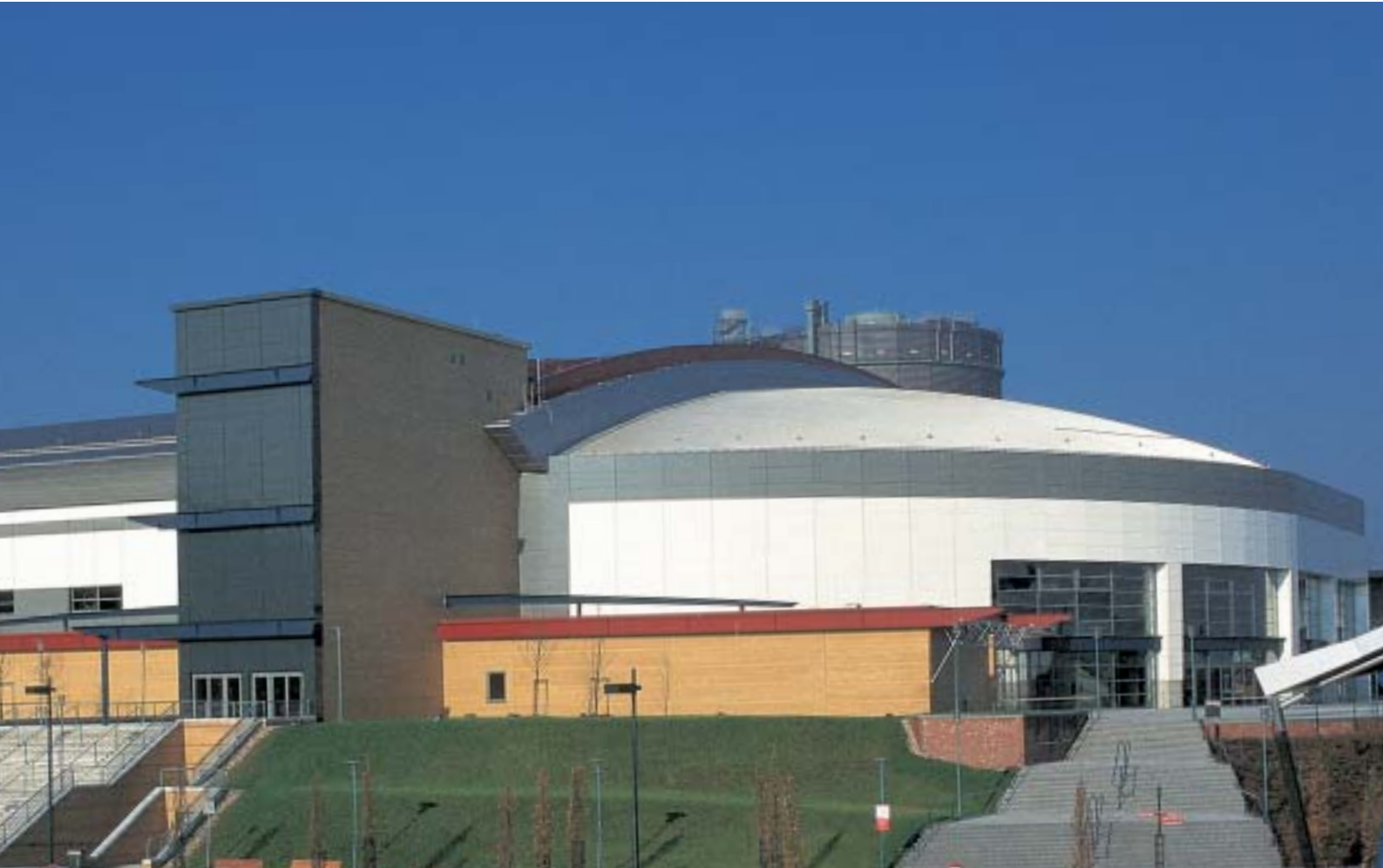
Arena Oberhausen (D), 1996. Kalzip® stucco naturel en RAL 8004. Architect DL. A. Ellerbe Becket, Wakefield (UK)
