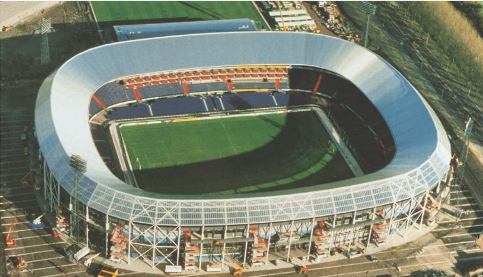
Stadion Feijenoord Rotterdam (NL), 1994. Kalzip® stucco naturel, gedeeltelijk conisch. Architecten: Zwarts & Jansma Abcoude/van de Broek & Bakema, Rotterdam
