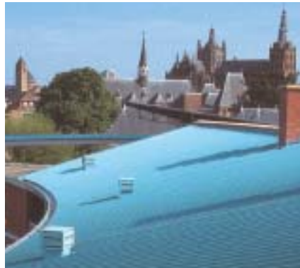
Arena Loefplein Den Bosch (NL) Architect: B+D Architecten, Oosterbeek
