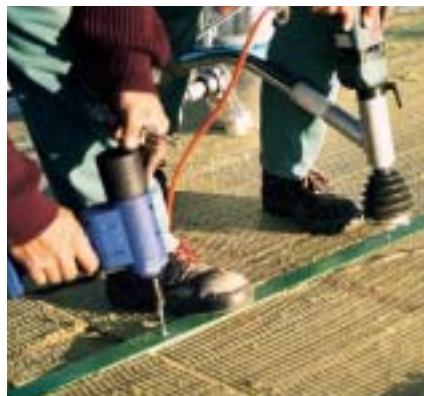
Het bevestigen van de profielen
