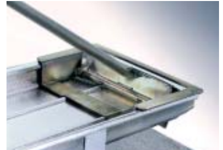
Een omzetting maakt het omzetten van de Kalzip® bodem t.p.v. de nok gemakkelijk
