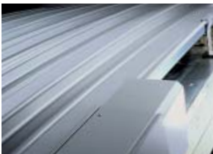
Lockform techniek zorgt voor rond met het dak meelopende dakranden
