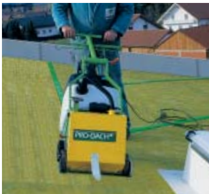
Het frezen van groeven voor de bevestigings-profielen
