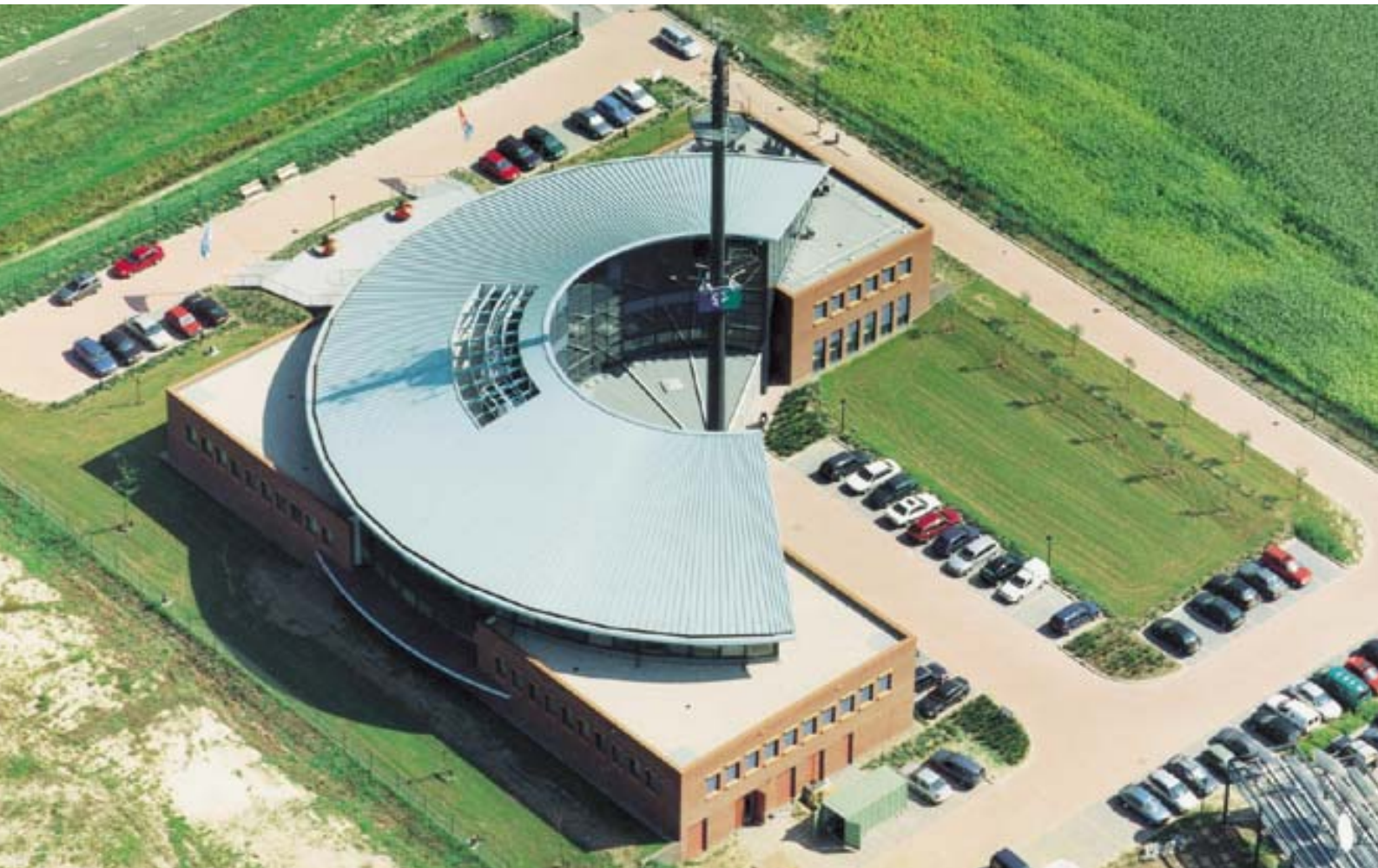
Kantoor U.P.C. Helmond (NL), Kalzip® afwerking koper antiek. Architect: Takenaka Amsterdam
