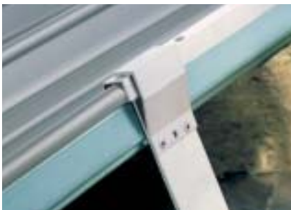
Stormhaak en klemprofiel ter versterking en verankering van de laatste kraal
