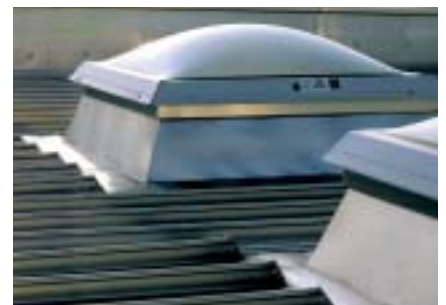
Opstanden voor lichtkoepels, ventilatoren of rookkanalen worden per project op maat gemaakt en ingelast
