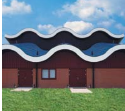
Pompstation Midden (NL) Architect: NV Waterleidingbedrijf, Midden
