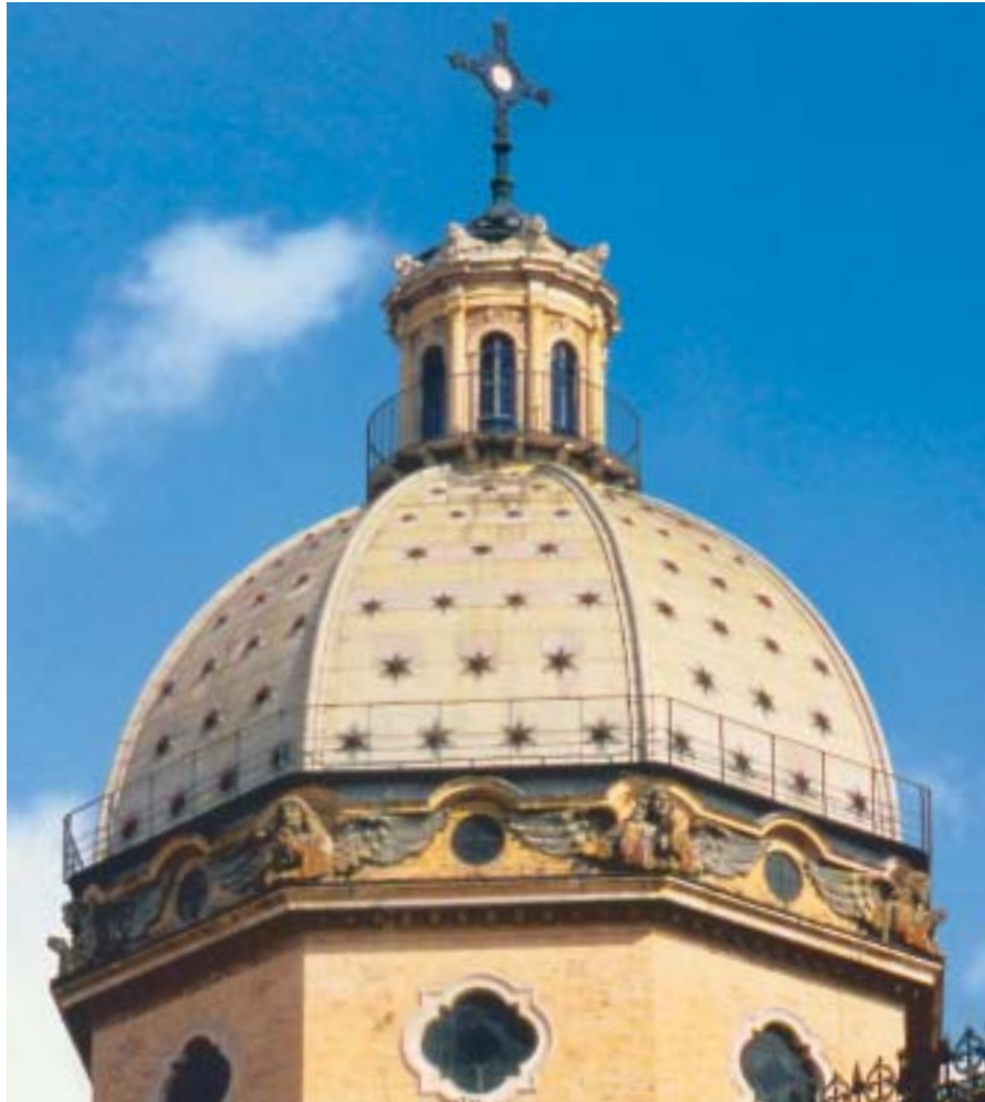
Koepel van de San Gioacchino kerk in Rome (I), 1897. Het oudste aluminium dak ter wereld
