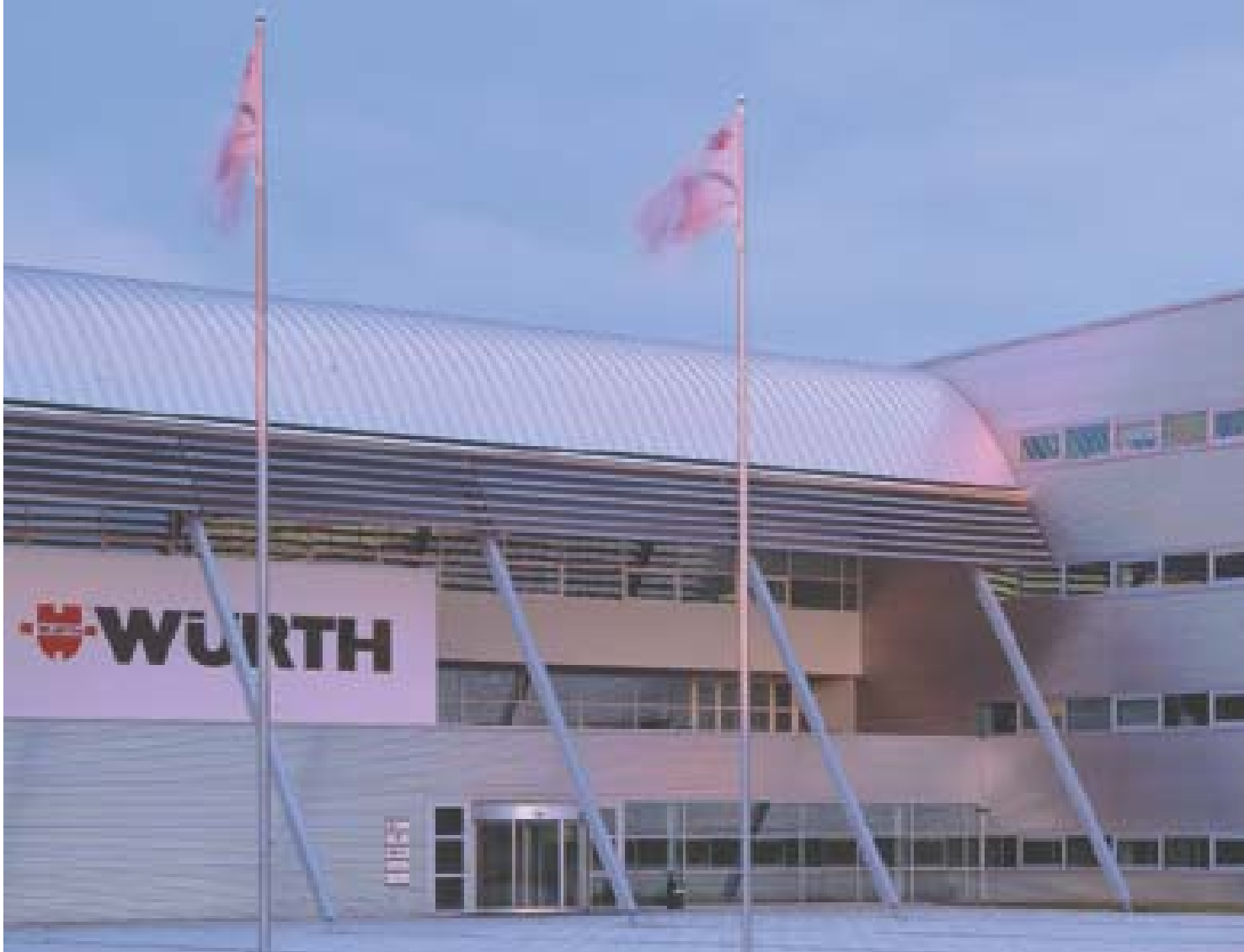
Kantoor- en distributiegebouw Würth, Den Bosch (NL), 2001. Kalzip® stucco rondgewalst, Kalbau® 18/76 stucco. Architect: De Twee Snoeken, Den Bosch
